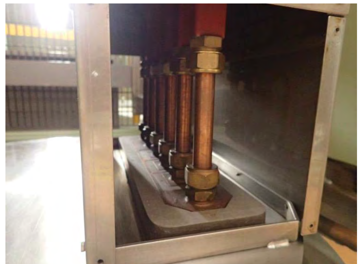
点検箇所④
